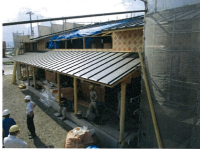
建設中のももの木保育園
